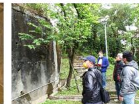
山坡地即時示警監控介接
