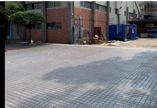
三重高中透水鋪面
