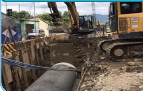
安和路新設雨水管涵
