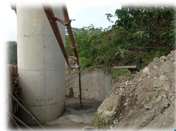
三鶯線墩柱CLSM灌漿作業
