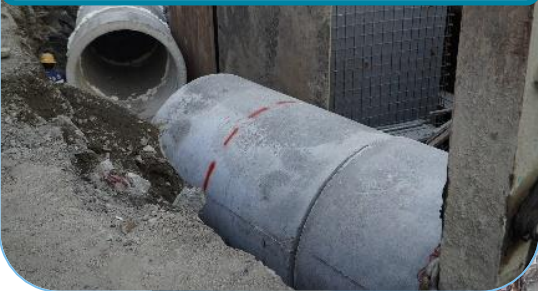
鶯桃路新設雨水管涵
