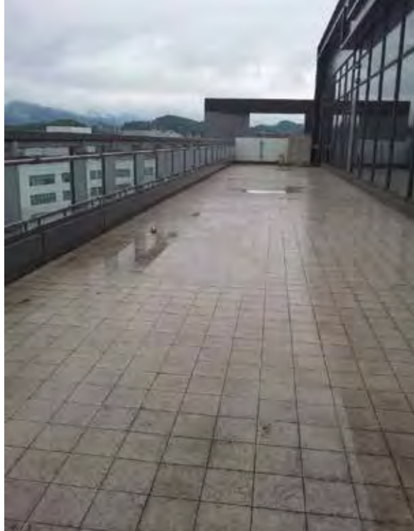
↓ ↑ 博瑞達公司未施工前露臺。
