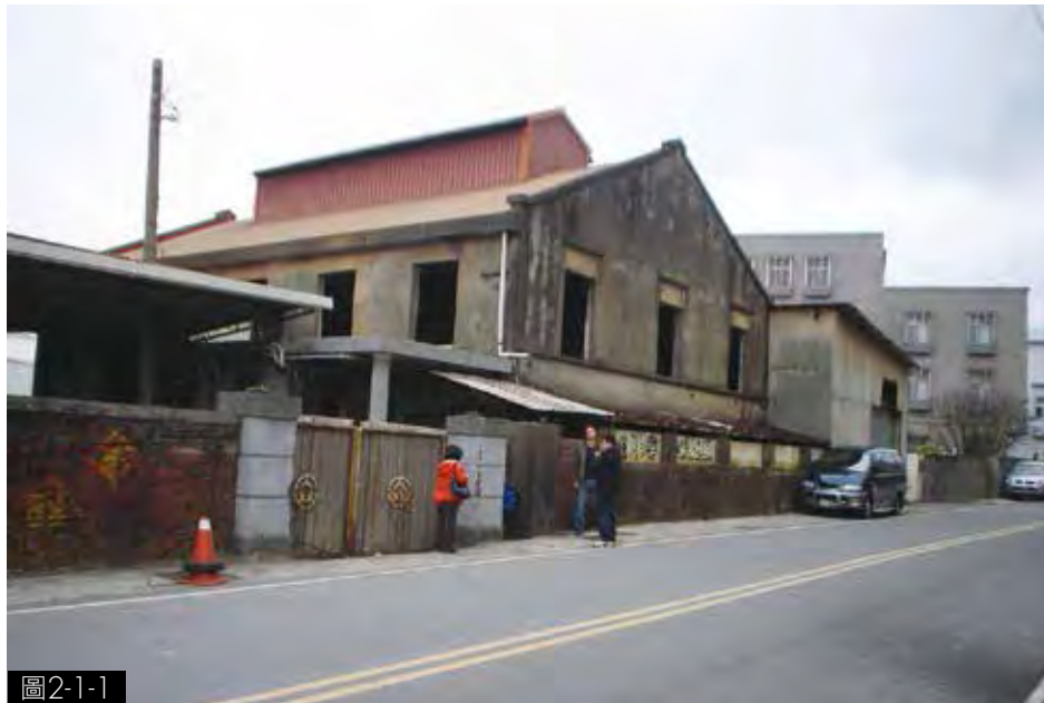
圖2-1-1 ↑鐵皮屋照片（新竹舊玻璃工廠）。（圖片來源：新竹縣社區網）
