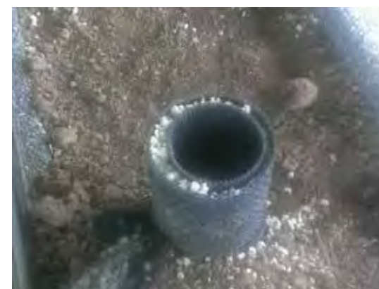
圖5-2-9 ↓ ↑ 落水頭與檢修孔防護。
