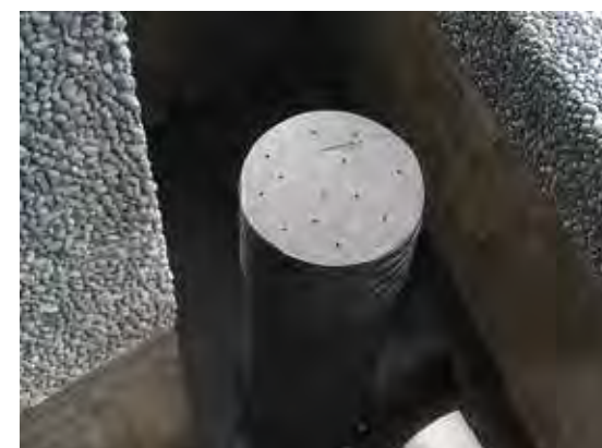
圖5-2-9 ↓ ↑ 落水頭與檢修孔防護。
